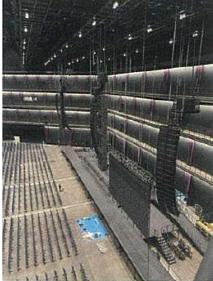
사진11 무대 상부 스피커
